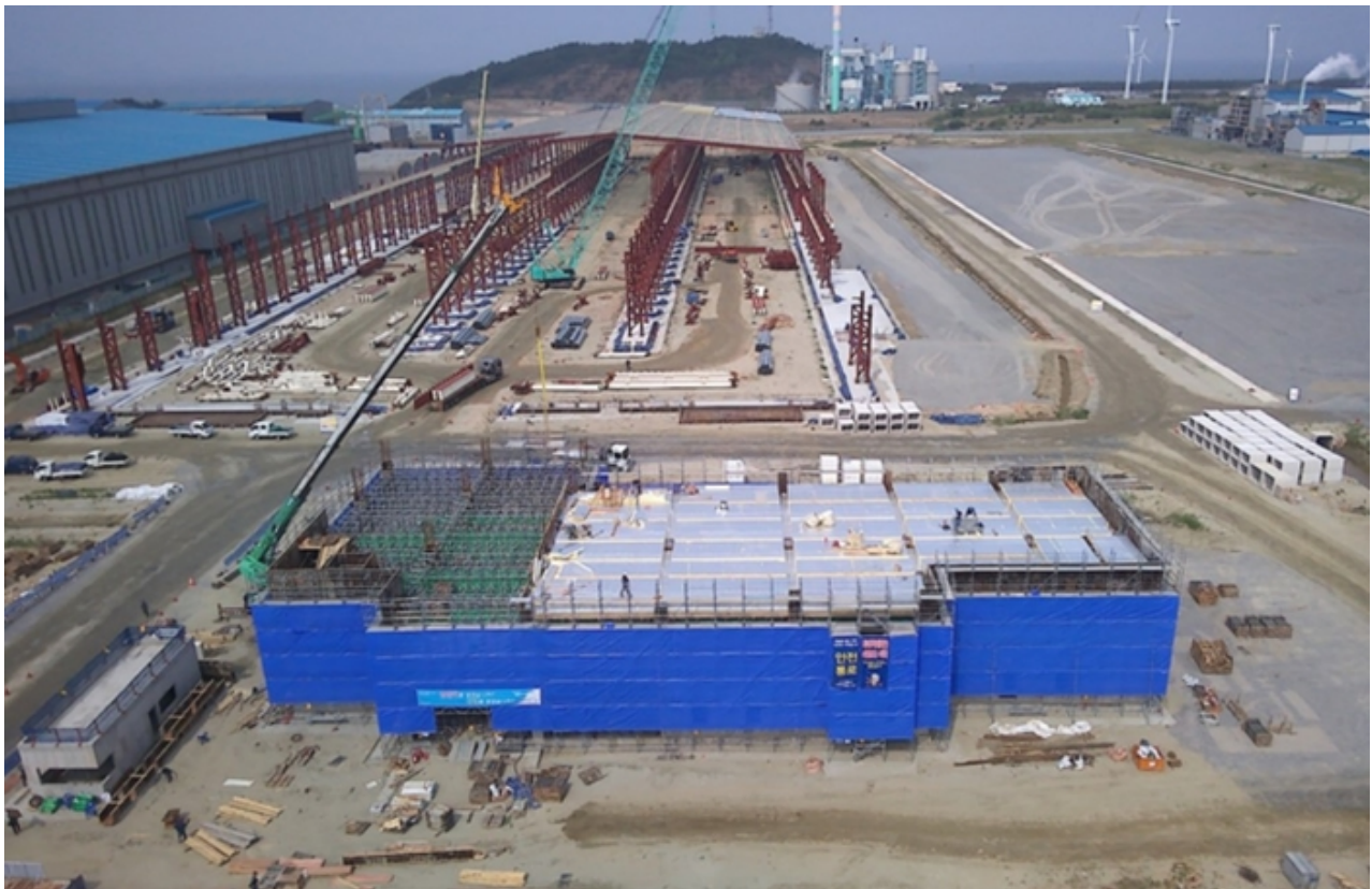
군산공장 건축 현장 [사진 = 휴스틸]
